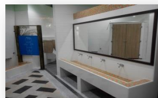
圖 17 完成整修之廁所
